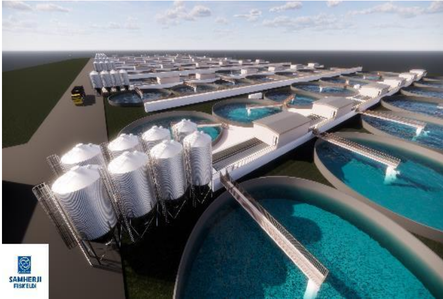
Mynd 6: Fóðursíló, staðsett milli eldiskerja.
